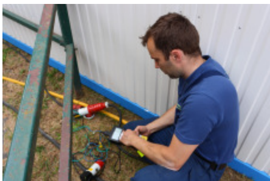
18.6.: Wir stellen wieder einmal die Verkabelung beim Finowcup sicher.
