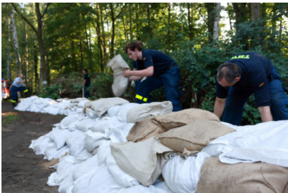
Aufbau eines Sandsackdeiches in Kiebusch/Cottbus.
