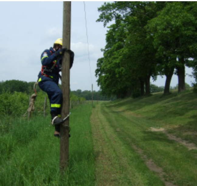
Marco Faustmann klettert auf einem Mast mit einer Telefonleitung, die abgehängt werden musste.
