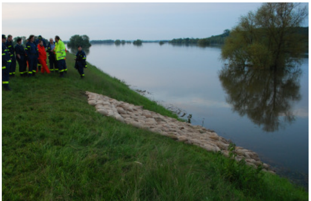
Eine der ausgebesserten Stellen am Deich bei Lunow.
