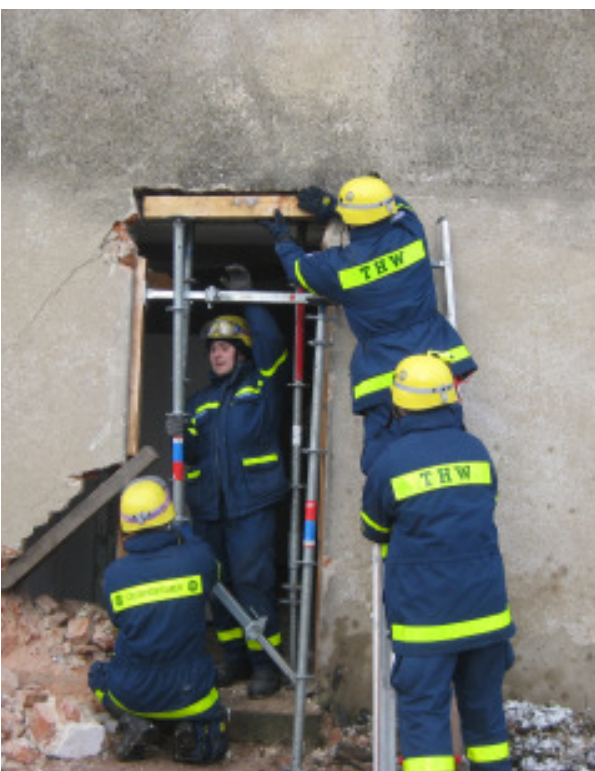
Helfer stützen den Türsturz und die Hausmauer ab.
