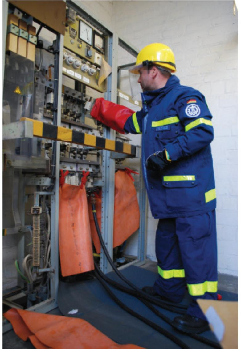
Oben: Matthias Dräger setzt Sicherungen ein, nachdem die Leitungen des Stromaggregats an die Trafostation angeschlossen waren.
