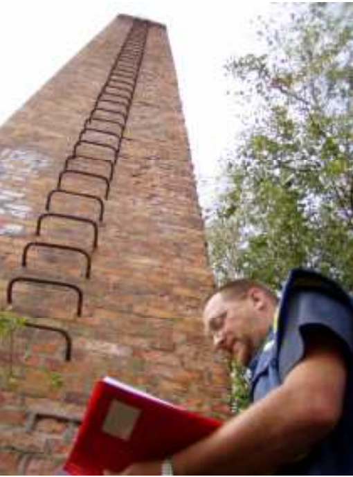
Das Übungsobjekt wird unter Leitung von Dirk Doll (OV-Fürstenwalde) bereits im Sommer zur Vorbereitung der Sprengung untersucht.
