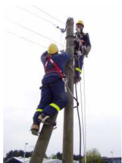
Bei der Ausbildung der Fachgruppe Elektroversorgung geht es auch mal hoch hinaus. Gruppenführer Daniel Förder und Helfer Arne Hildebrandt bei der Ausbildung zum Thema Leitungsbau.
