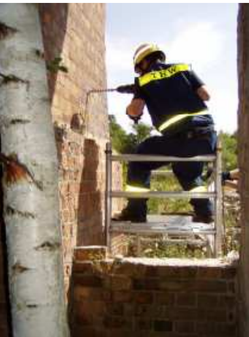
Helfer der Eberswalder Bergungsgruppe führen Probebohrungen durch, damit der Zustand des Schornsteins analysiert werden kann. Die richtige Sprengdosis hängt stark vom baulichen Zustand ab.
