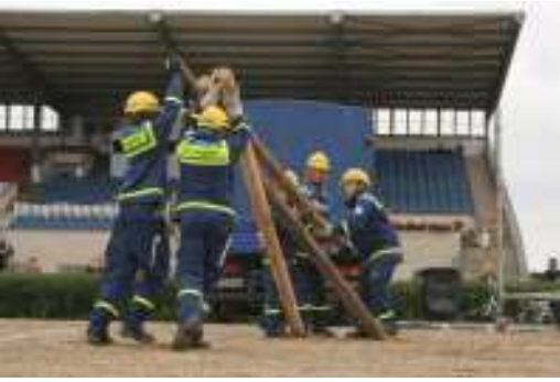
Der Dreibock, die Basis für eine Seilbahn wird mit gemeinsamen Kräften aufgerichtet.
