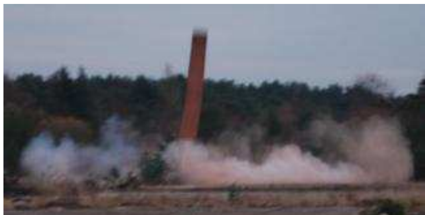
Der Abschluss einer erfolgreichen Vorbereitung. Nach einem großen Knall fällt der Schornstein wie gewünscht zusammen.
