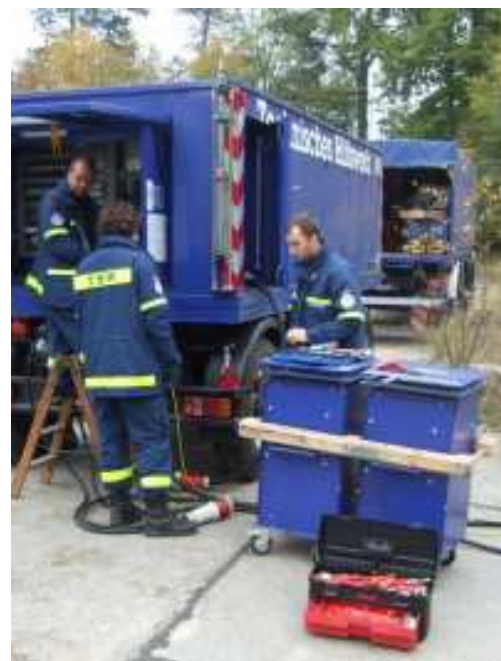
Bei der Notstromversorgung hängt alles von einer guten Vorbereitung ab, damit dann alles zuverlässig läuft. Hier v.l.n.r. Matthias Dräger, Marco Faustmann und David Sebök bei den Vorbereitungen.
