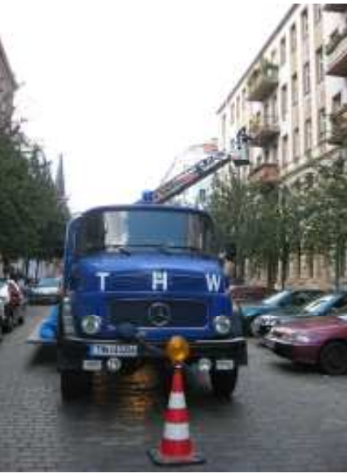
Der Eberswalder GKW in Berlin. Im Hintergrund eine Drehleiter der Berliner Feuerwehr mit dem Helfer Peter Hoppe zur Beseitigung von losen Putz.
