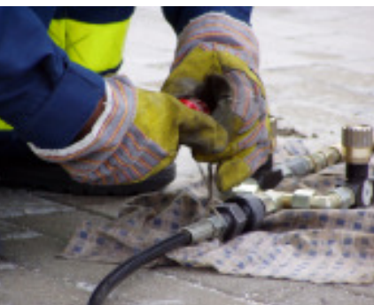
Die Hydraulikschläuche lassen sich immer besonders schwer zusammenkuppeln
