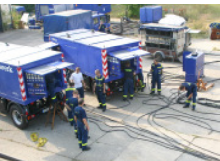
Die Netzersatzanlagen werden startklar gemacht.
