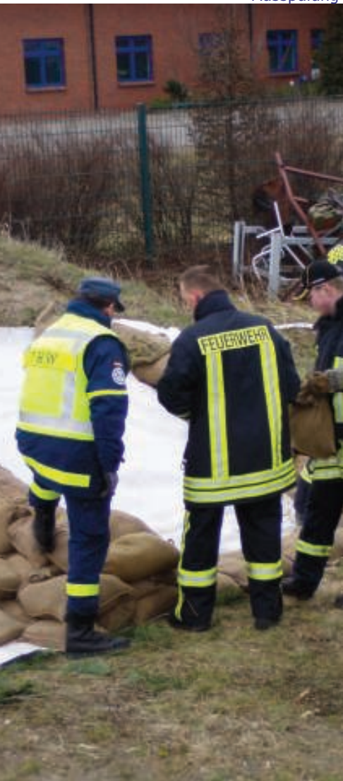
Feuerwehrkräfte sicherten einen Deich gegen austretendes Wasser und schützten ihn so vor der Ausspülung
