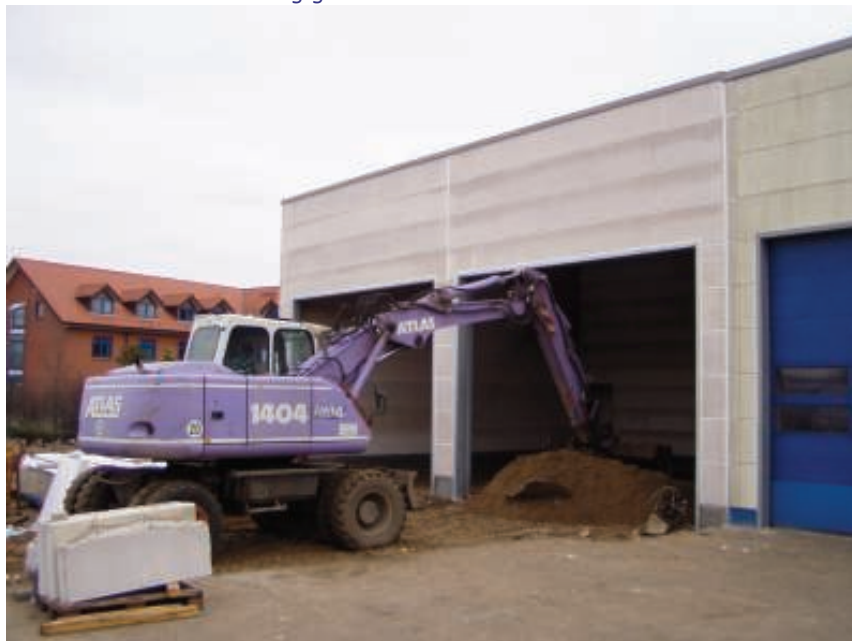
Ende November waren Wände und Dach des neuen Hallenanbaus bereits fertig gestellt.
