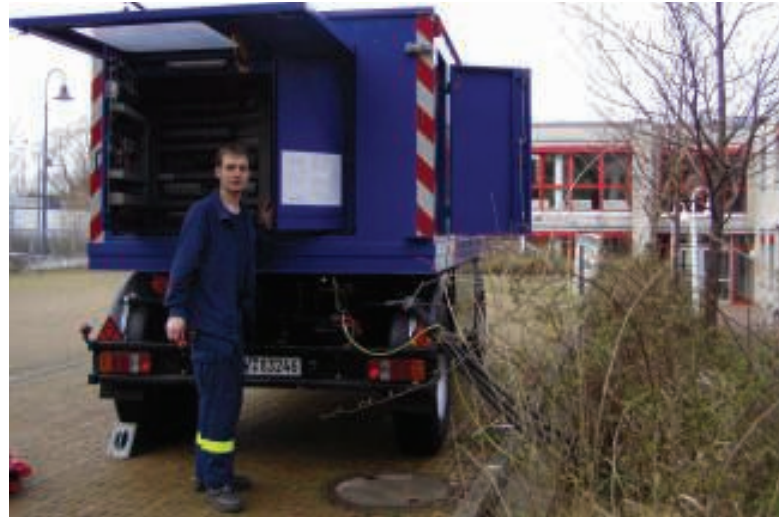
Das Notstrom-Aggregat war im März auf dem Parkplatz der Leitstelle abgestellt. Während der Bauarbeiten stellte es sicher, dass die Leitstelle bei einem Stromausfall weiterhin versorgt wird.
