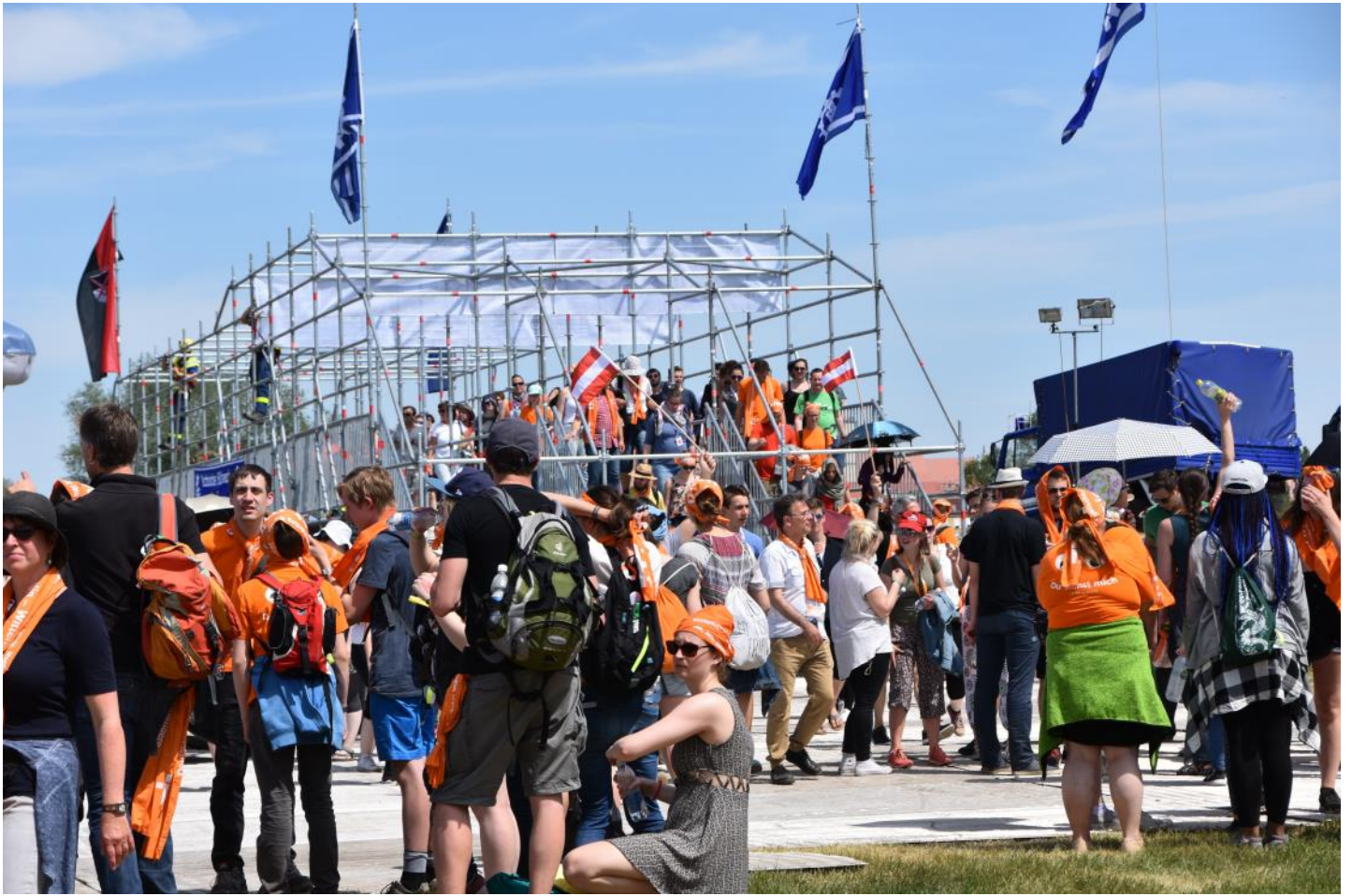
Regerer Andrang beim vom THW errichteten Übergang aus Einsatzgerüstsystemen. Foto: Juliane Schwartz
