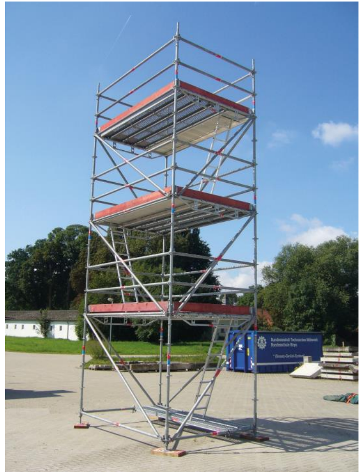
Der Übungsturm mit drei Arbeitsplattformen aus dem EGS (Foto: EGS-Handbuch)
