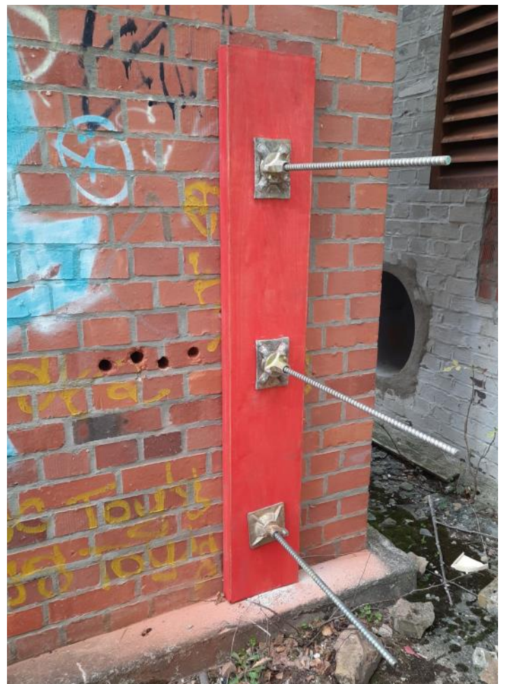
Holzformteil mit Ankerstäben zur Sicherung einer Wand mit Hilfe des Rüstholzsatzes (Foto: Leonard Winter)
