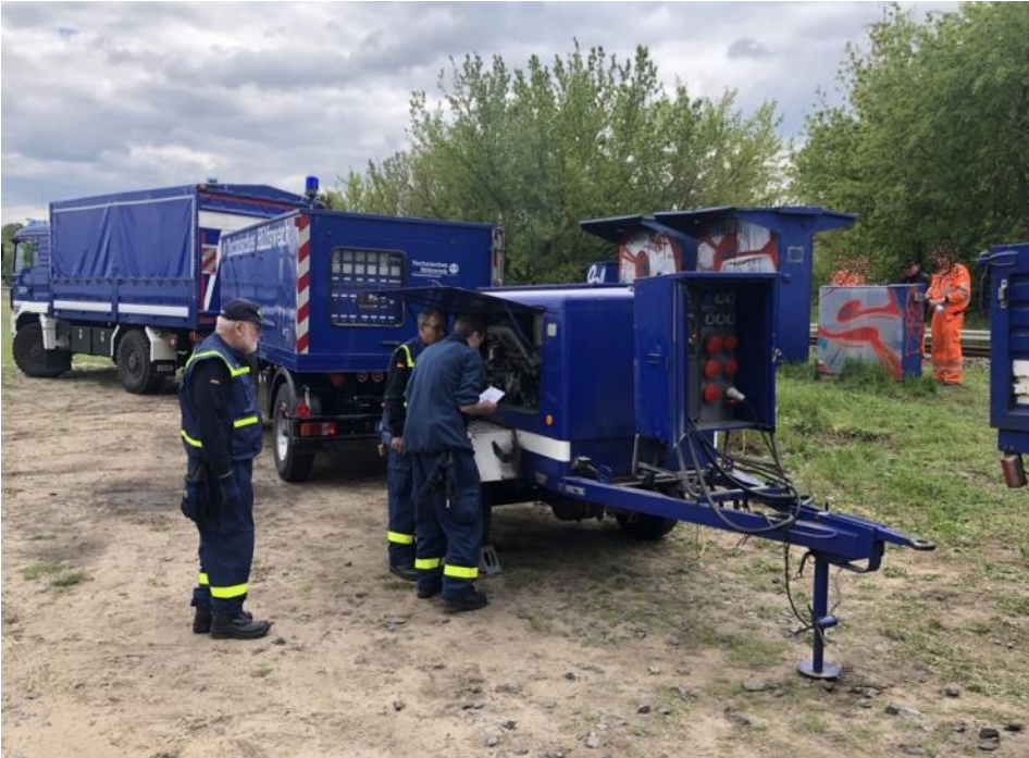
Vorbereitung des 50 kVA-Aggregates vor der Inbetriebnahme (Foto: Matthias Lamprecht)
