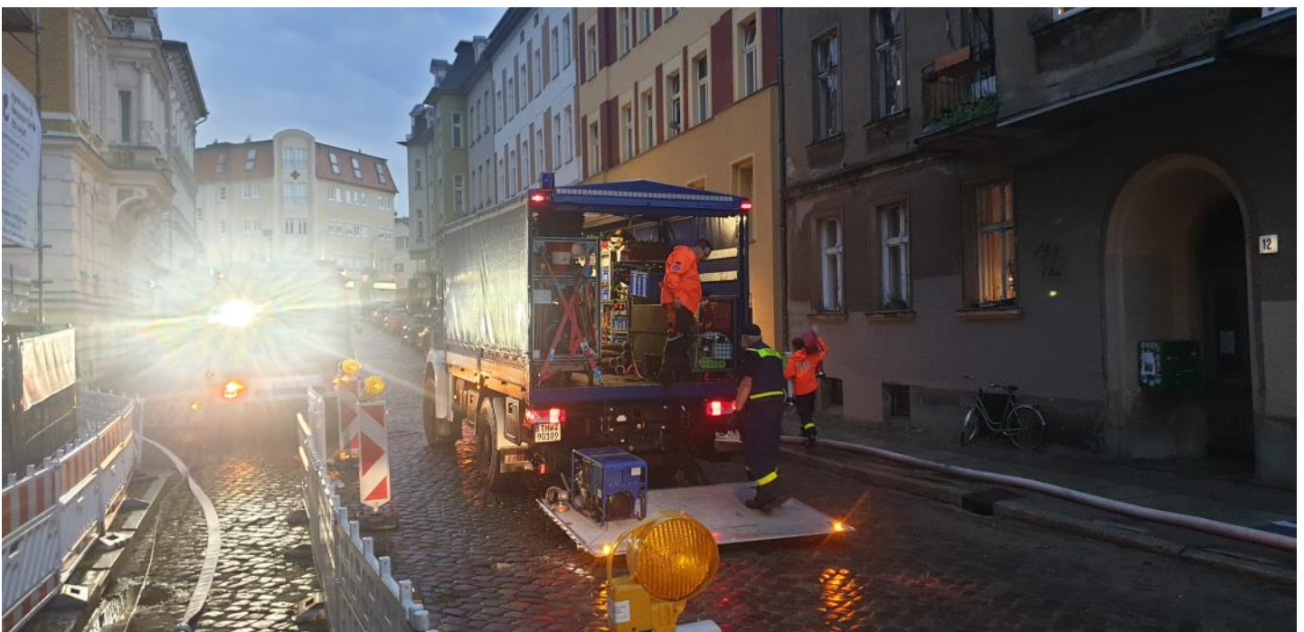
Einsatz in der Weinbergstraße in Eberswalde. Notwendige Ausstattung wird entladen. (Foto: Christian Richter)
