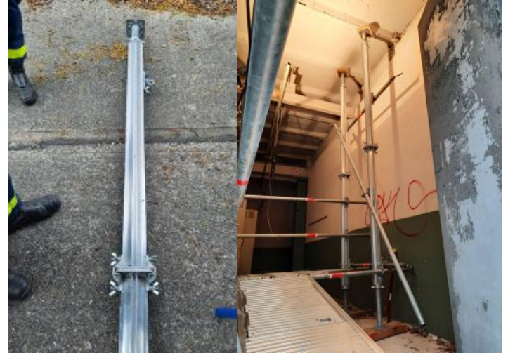
Spindelstütze als Einzelansicht verbaut mit Teilen des Rüstholzsatzes (Fotos: Leonard Winter)
